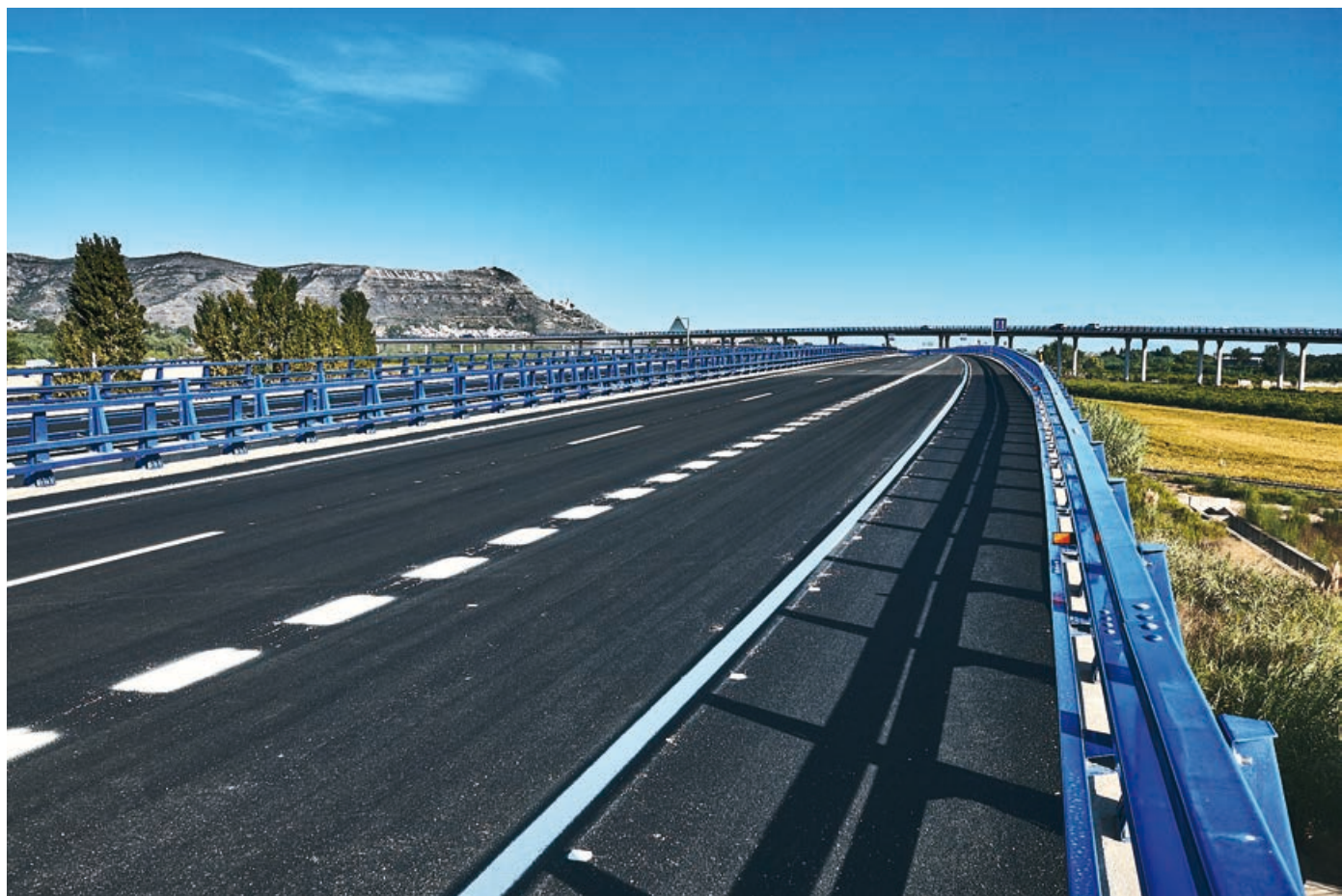
Pretil metálico META16®. Autovía A-38. Cullera (Valencia)
