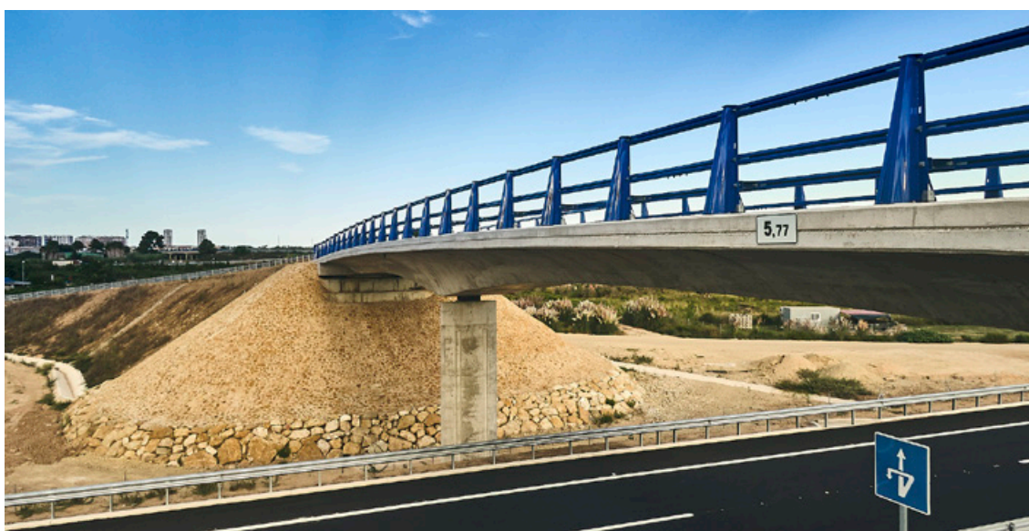
Pretil metálico META16®. Autovía A-38. Cullera, Valencia
