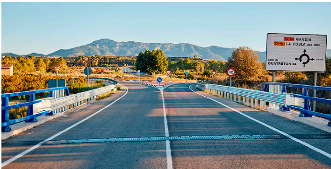
Transición entre pretil metálico META13® y barrera flexible. CV-611. Benigánim, Valencia
