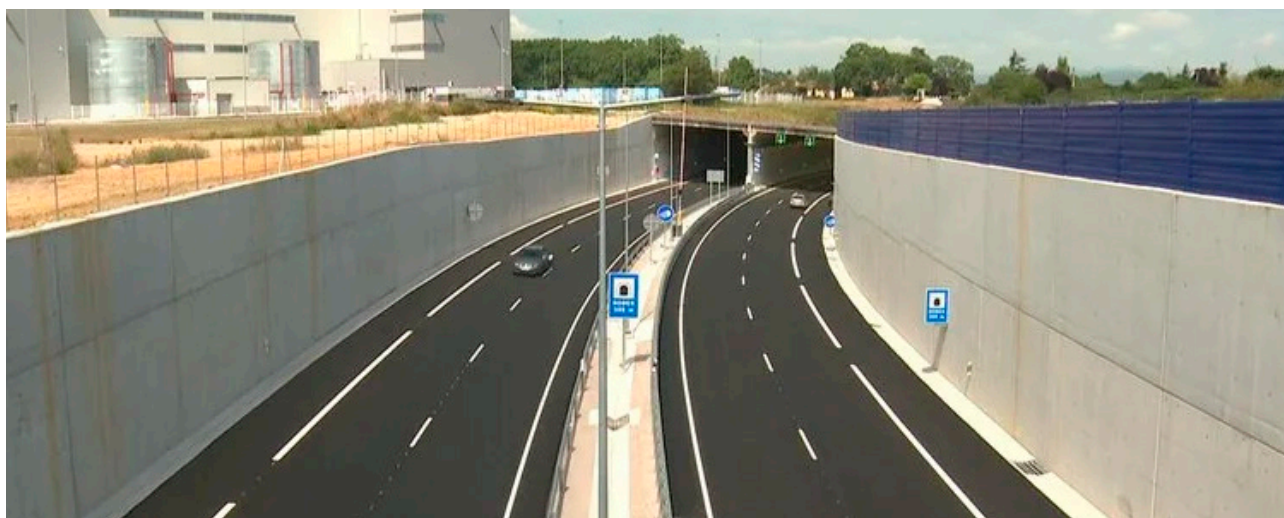
Desdoblamiento AS-17, Tramo Avilés - Riaño, Asturias
