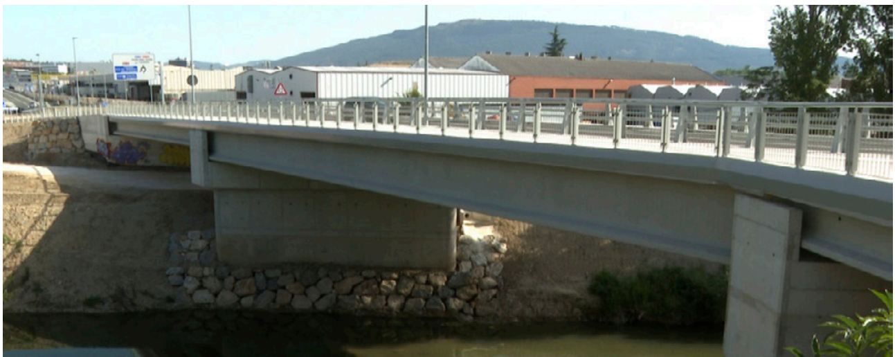
Pretil metálico META13®, Nuevo vial de conexión NA-30 Barañain con Landaben, Navarra
