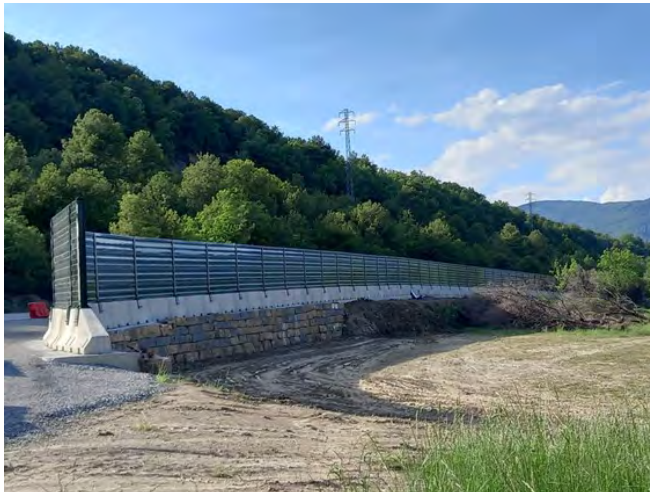
Foto 4. Pantalla sobre barrera de hormigón existente
