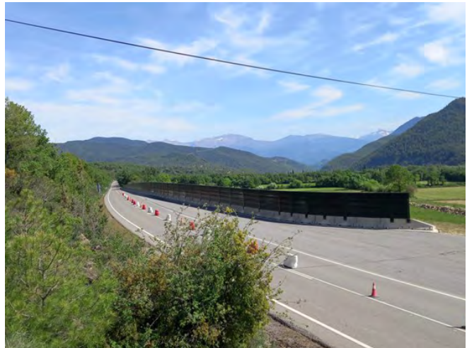
Foto 5. Pantalla sobre barrera de hormigón existente
