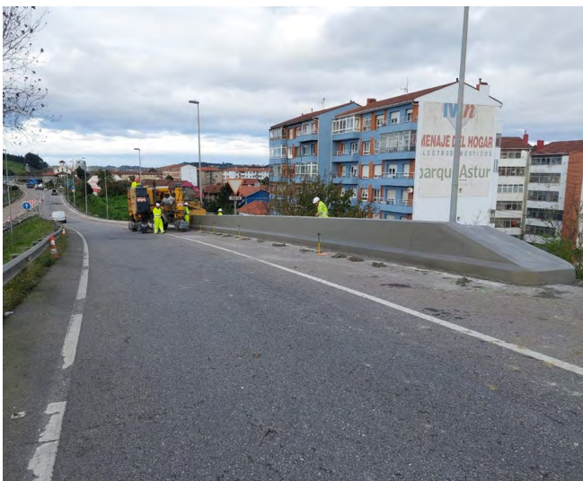
Foto 11. Instalación De Sistema Integrado
