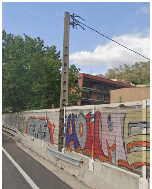
Foto 3. Pantalla sobre barrera de hormigón sin marcado CE
