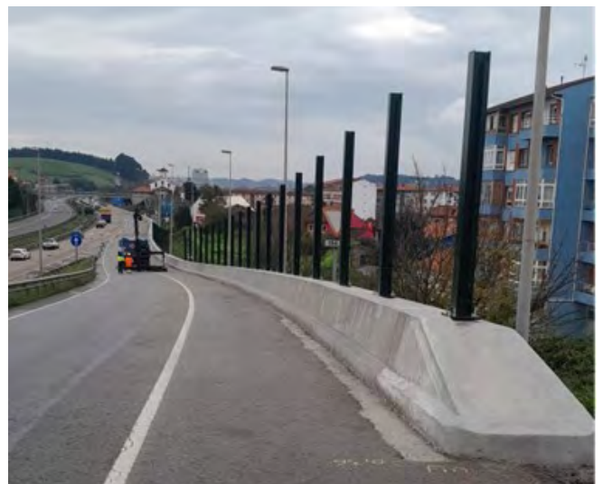
Foto 12. Instalación De Sistema Integrado
