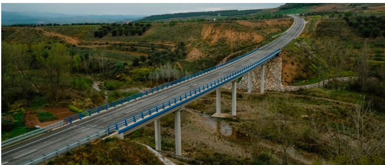
Pretil metálico META13®. Carretera LR-259 a la LR-261.Variante de Murillo de Río Leza, La Rioja
