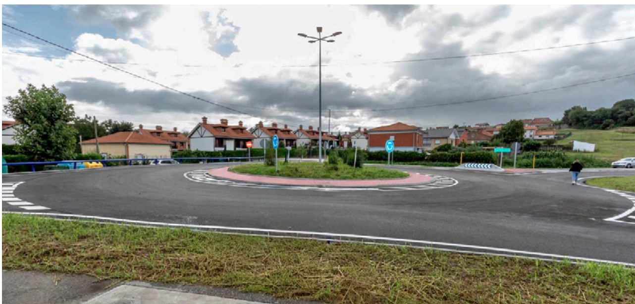
Pretil metálico Metaurban®, Acondicionamiento intersección CA-330. Travesía Polanco (Cantabria)
