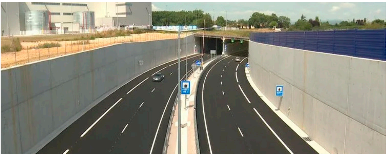
Desdoblamiento AS-17, Tramo Avilés - Riaño, Asturias
