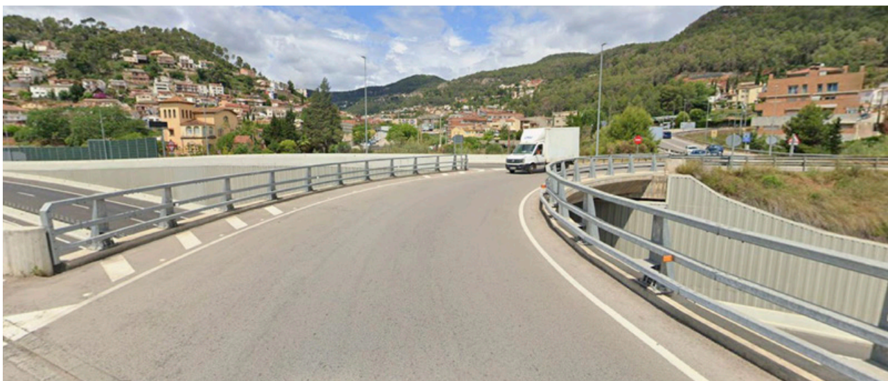
Pretil metálico META16®. Autovía B-24, Variante de Vallirana, Barcelona.
