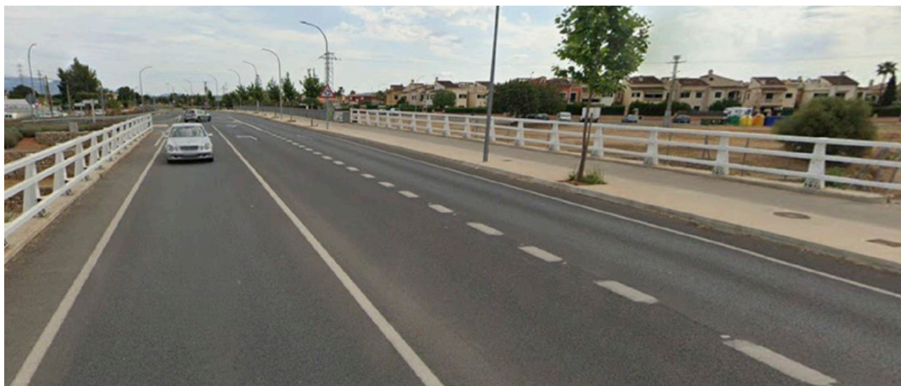
Pretil metálico META13®. Carretera MA-2031 Vella de Bunyola, a la altura de Torrent Gros, Palma de Mallorca
