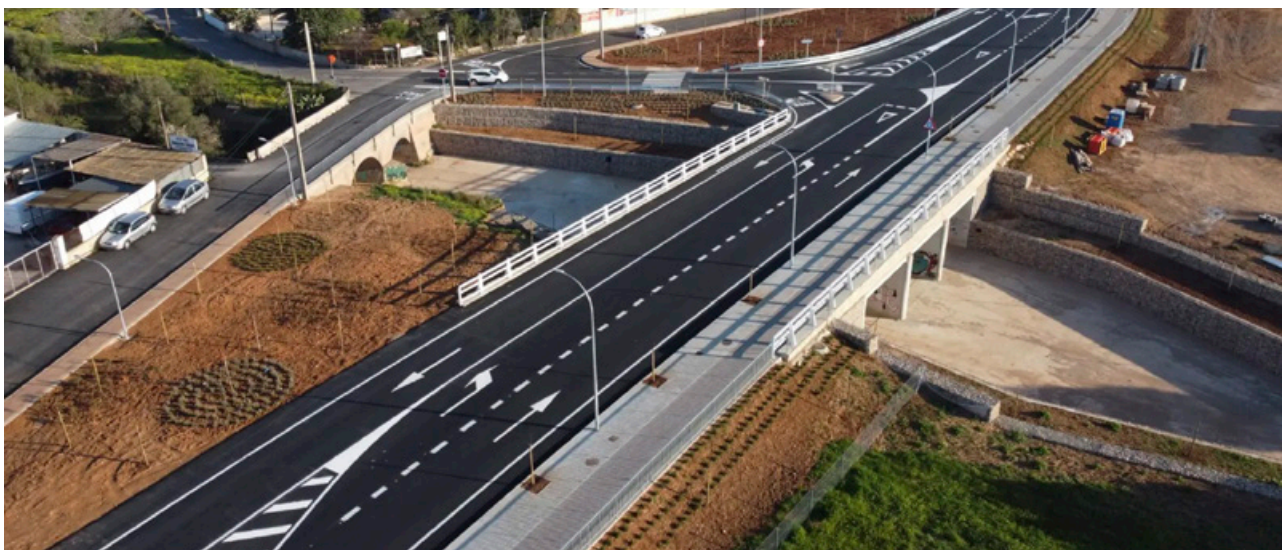
Pretil metálico META13®. Carretera MA-2031, enlace de urbanizaciones entre Palma y Marratxí, Palma de Mallorca.
