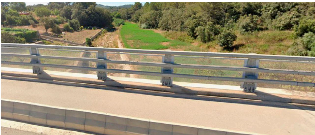
Pretil metálico META13®. Carretera Ma-12, Puente de la carretera Artà, Mallorca.
